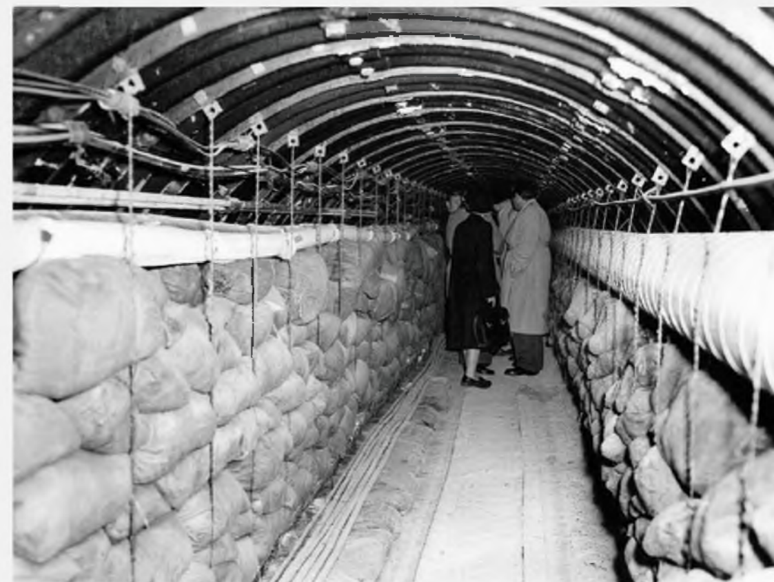
Приглашенные журналисты осматривают туннель. 24 апреля 1956 года
